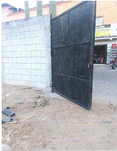
Foto 1: Mantenimiento de portones
