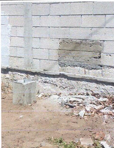
Foto 3: Reparación de muros de contención
