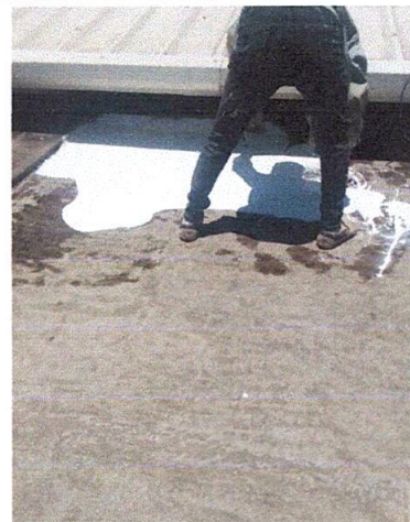
Foto 4: Impermeabilización
