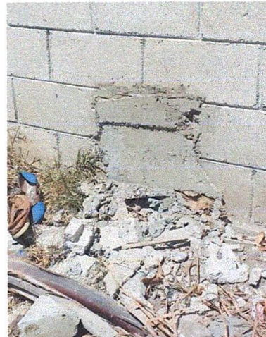
Foto 4: Reparación de muros de contención
