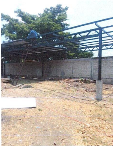
Foto 1: Cubierta de lámina.
