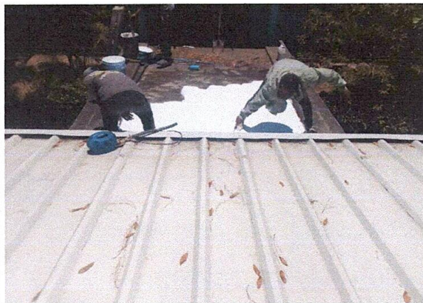
Foto 3: Impermeabilización
